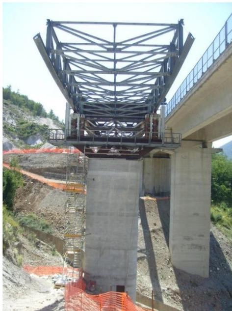
Tale tecnologia, consolidata da lungo tempo, permette di operare sempre in sospensione, senza ausili di gru o altri macchinari ingombranti da terra e con spinte frazionate e traslazioni laterali in grado di meglio adattarsi alla particolarità del tracciato, con la coesistenza di tratti rettilinei e tratti in curva.
