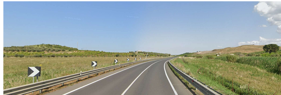
Tratto di SS 417
