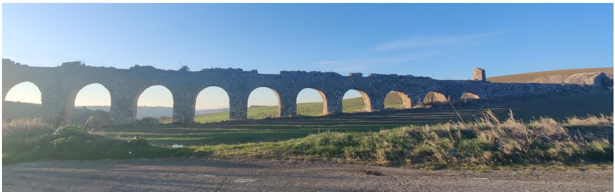
Figura 81 – Tratto dell'acquedotto settecentesco lungo la SS1bis tra il promontorio dei Monterozzi e l'Ara della Regina – Pian di Civita
