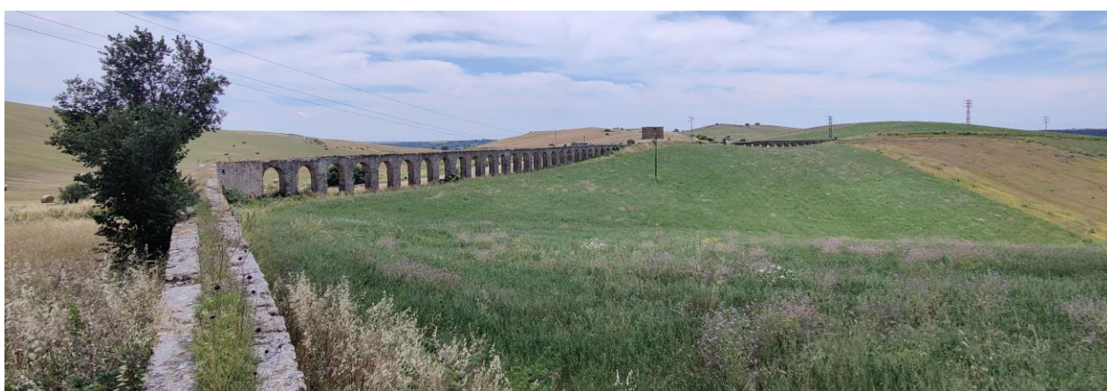
Figura 157 –Sopra e in mezzo: uno dei tratti in elevazione dell’acquedotto settecentesco all’incrocio tra via Ripagretta e la Strada vicinale degli archi (itinerario A). Si intravede anche il percorso che, passando sotto gli archi, conduce alla valle del San Savino per risalire poi verso il Pian di Civita – Ara della Regina e il “parco degli “acquedotti” (itinerario C) Sotto: Area degli acquedotti lungo la SS1bi (itinerario A) andando verso l’area della Regina e Pian di Civita
